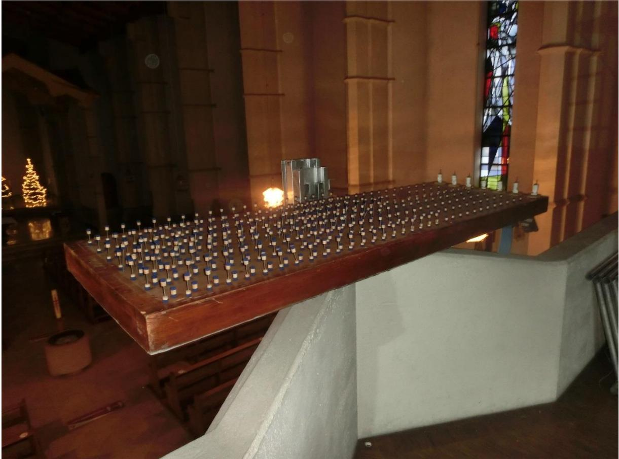
Ausgebaute Kegellade des Unterwerkes und Transport mittels eines Hubwagens
