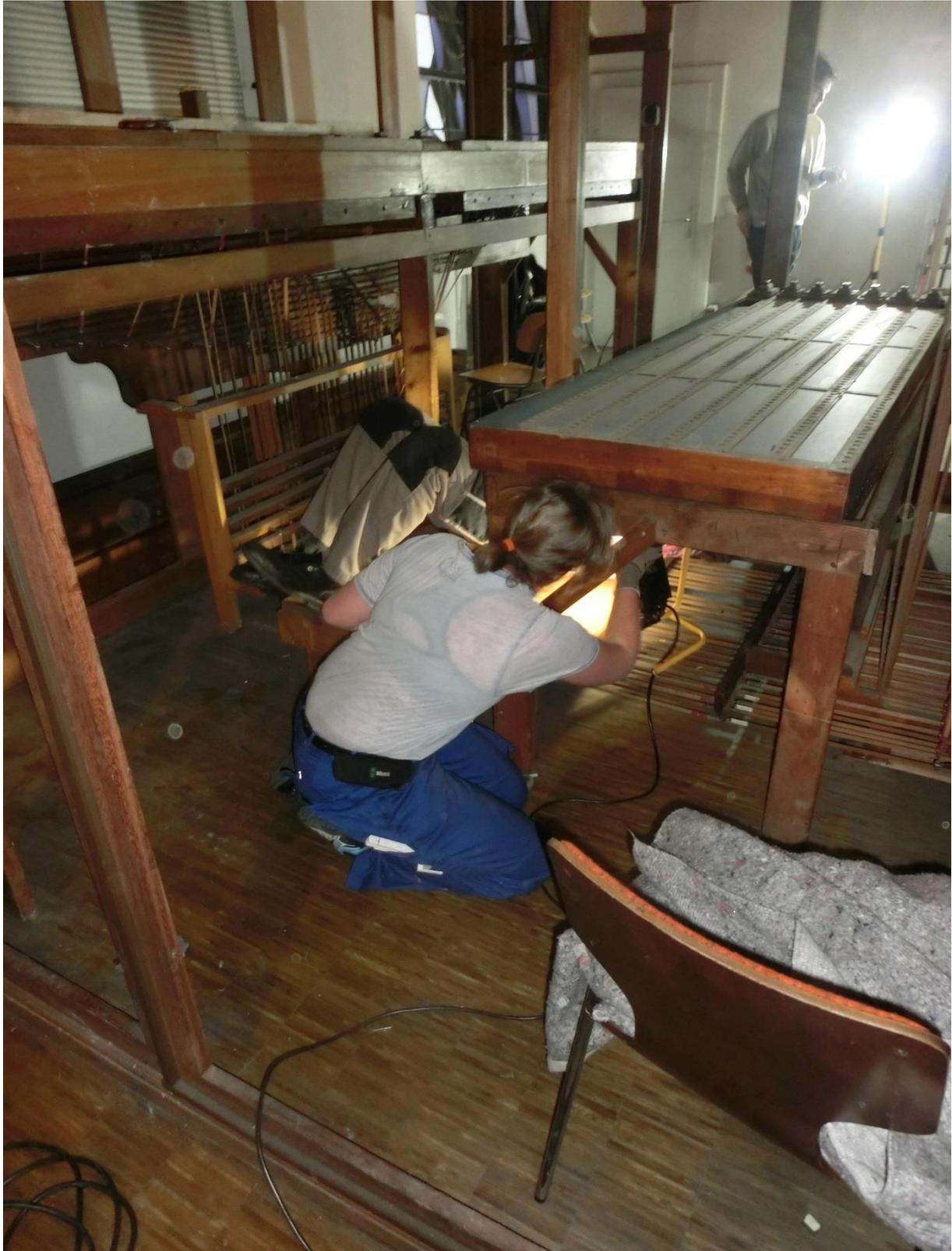
Ausbau der Windversorgung und Abkleben sämtlicher mechanischer Spieltrakturen sowie der Registermechanik
